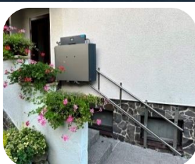
Wejście zamknięte stacja zewnętrzna
